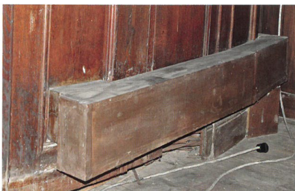
Voorzijde van de kast vóór restauratie, onderaan open gezaagd en met het Beckers windkanaal erboven
