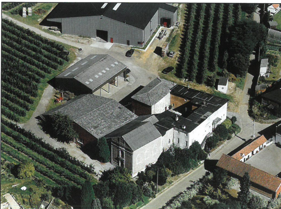
De overblijvende gebouwen van de voormalige kluis van Reinrode in Halen maken nu deel uit van een fruitbedrijf.
